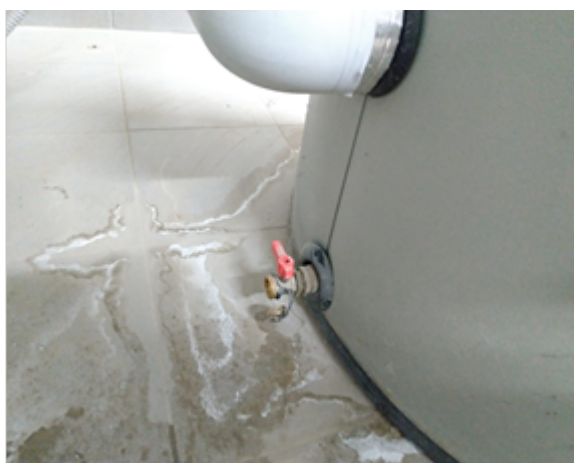
Fig. 3 – particolare scarico fondo boiler
